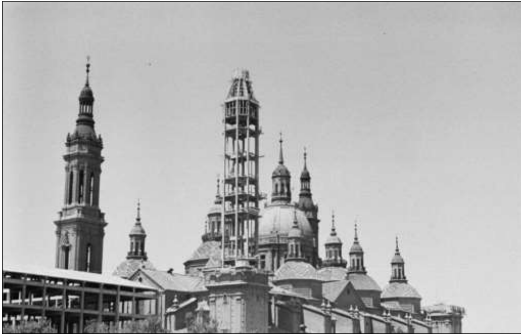
El Pilar con la 2ª torre en construcción (Archivo Herald)
