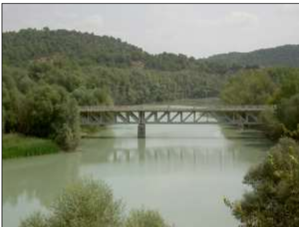
Puente de Ardisa sobre el Gállego (Blas Sorribas)
